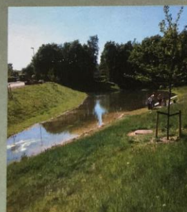
Et regnvandsbassin i Risvangen med rekreative muligheder. Vandet tilbageholdes, når det regner kraftigt.
